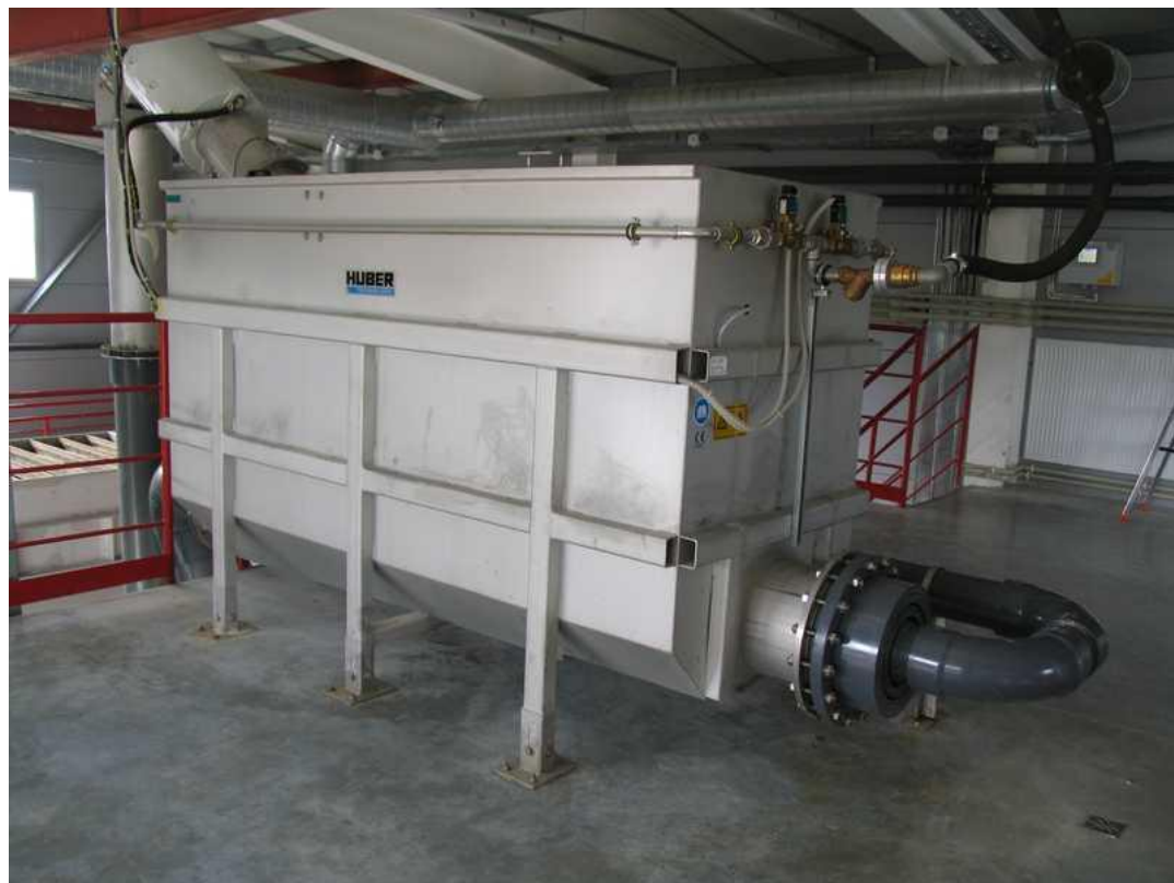
Экран мелкой очистки HUBER RO 2 1000/1 мм
